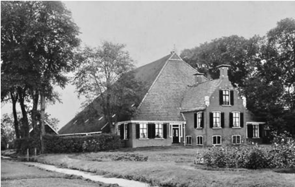
“Arbeid en Moeite” (later “De Eersteling”) te Ypecolsga
